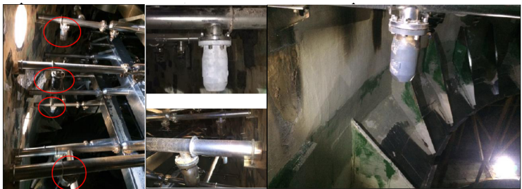
Фигура 4. Експериментален монтаж на аксиални дюзи тип „плътен конус“ в участък по периферията на трето дюзово ниво и на първо дюзово ниво над двата ръба на козирката на фукса на абсорбер 1
