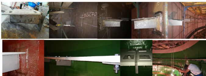
Фигура 6. Изработване и монтаж на отражателен пръстен в абсорбер 2
