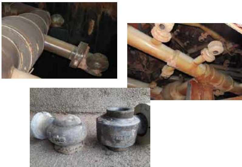
Фиг. 2. Дюзи на дюзовите нива преди модернизацията
