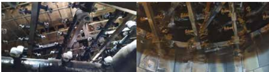
Фиг. 7. Извършена модернизация на СОИ 8:
