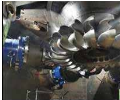
Фиг.4 Нови дюзи и дефлектори за всяка турбина/ ВЕЦ Сестримо
