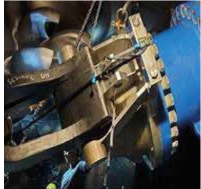
Фиг. 2 Дюзи и дефлектори за всяка турбина /ПАВЕЦ Белмекен
